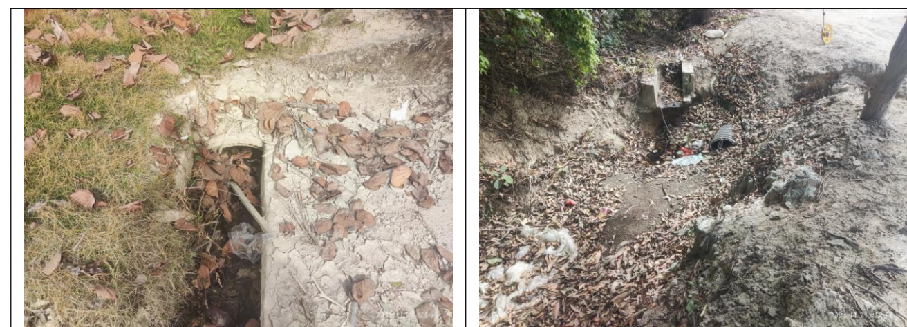
图 3.2 K14+442~K14+510 圆管涵段淤积严重
